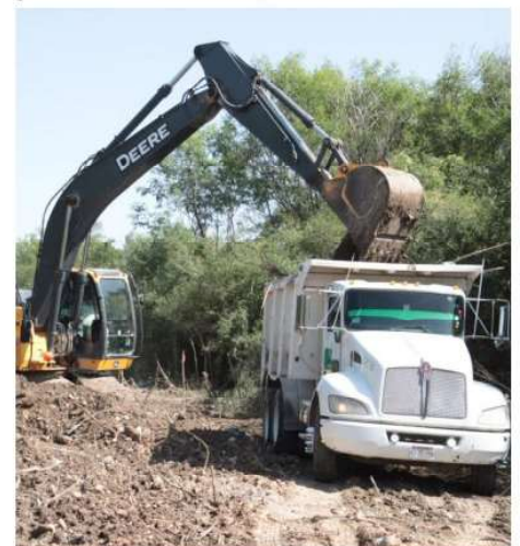
De inmediato iniciaron los trabajos para la canalización.
